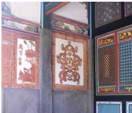
圖 115 - 三落大厝 正堂前廊
