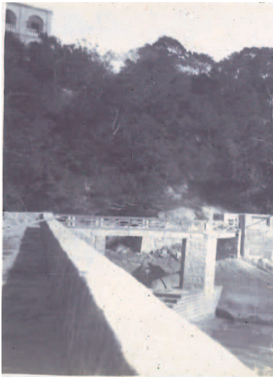
羨魚臺附近的隱龜橋正在進行工事，右方為枕流石。
