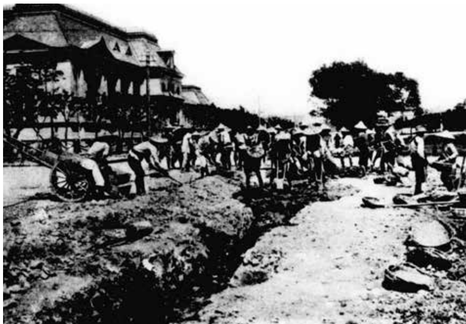
臺北自來水管線鋪設工程。（圖片來源：《臺灣水道誌》，1918年）
